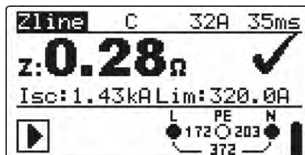
Linia do linii
