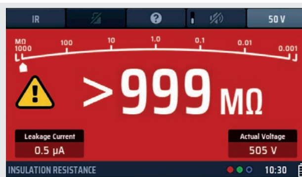
Afb.21: Isolatie weerstandstest wordt uitgevoerd
