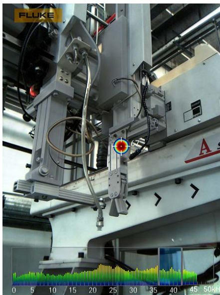
Detectie van persluchtlekage in industriële machines
