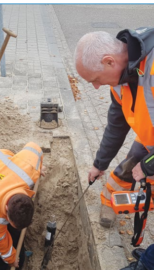
Meting tijdens graafwerkzaamheden
