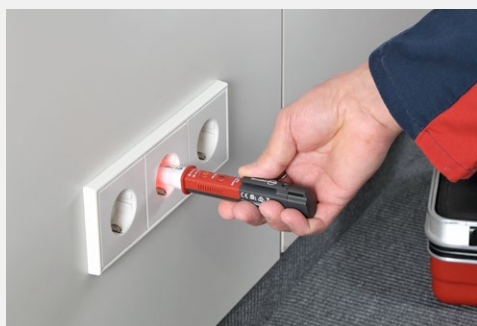
Testen van wandcontactdozen voor AC-spanning en polariteit
